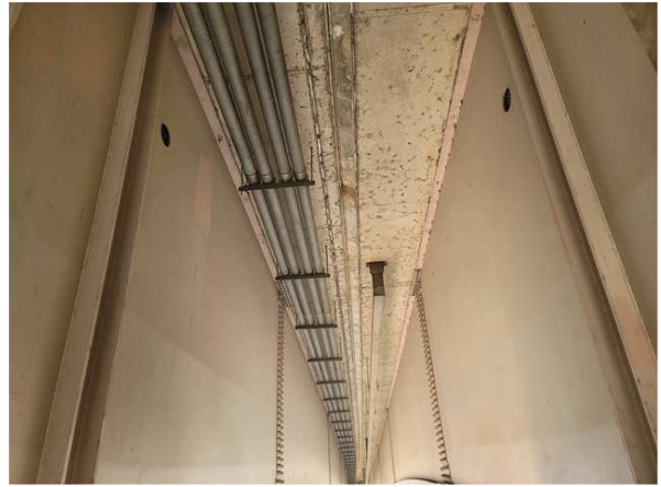
바닥관하면 S5 내측 캔틸레버 상태현황
