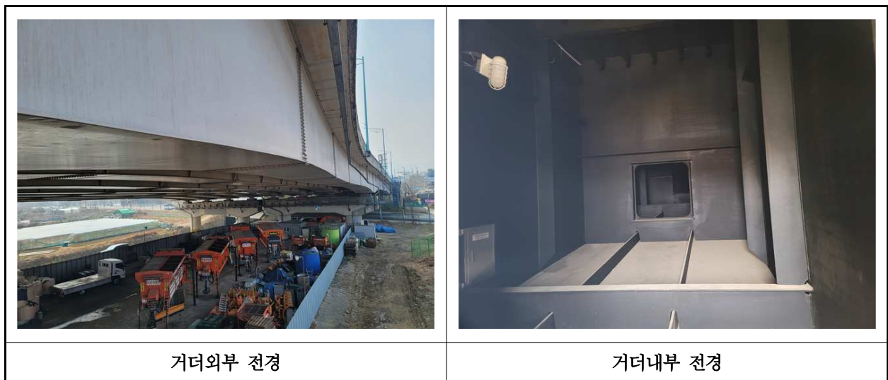
【사진 2.3.4】 거더 전경
