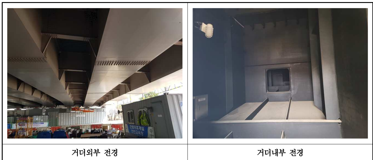
【사진 2.3.34】 거더 전경
