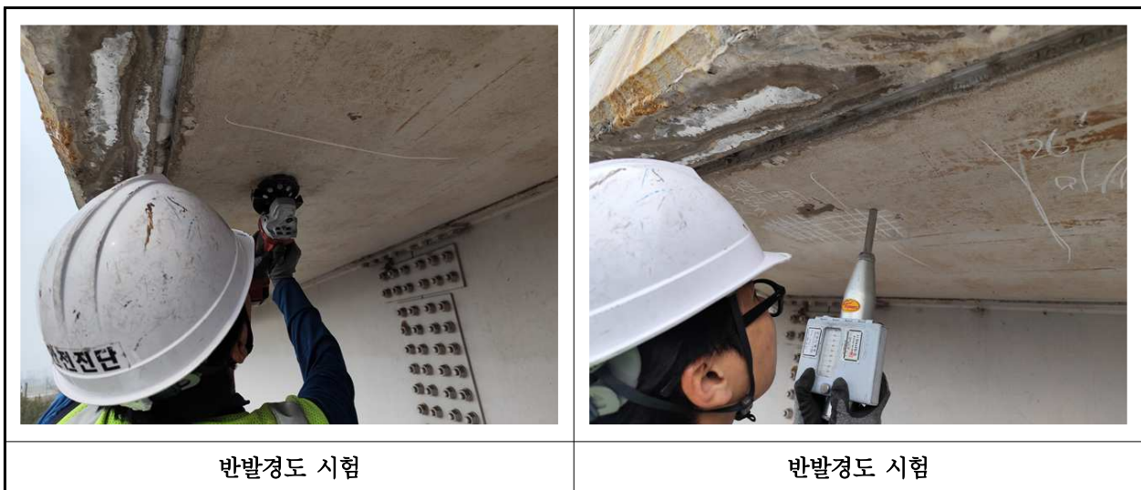
【사진 2.4.2】 반발경도시험 현장사진
