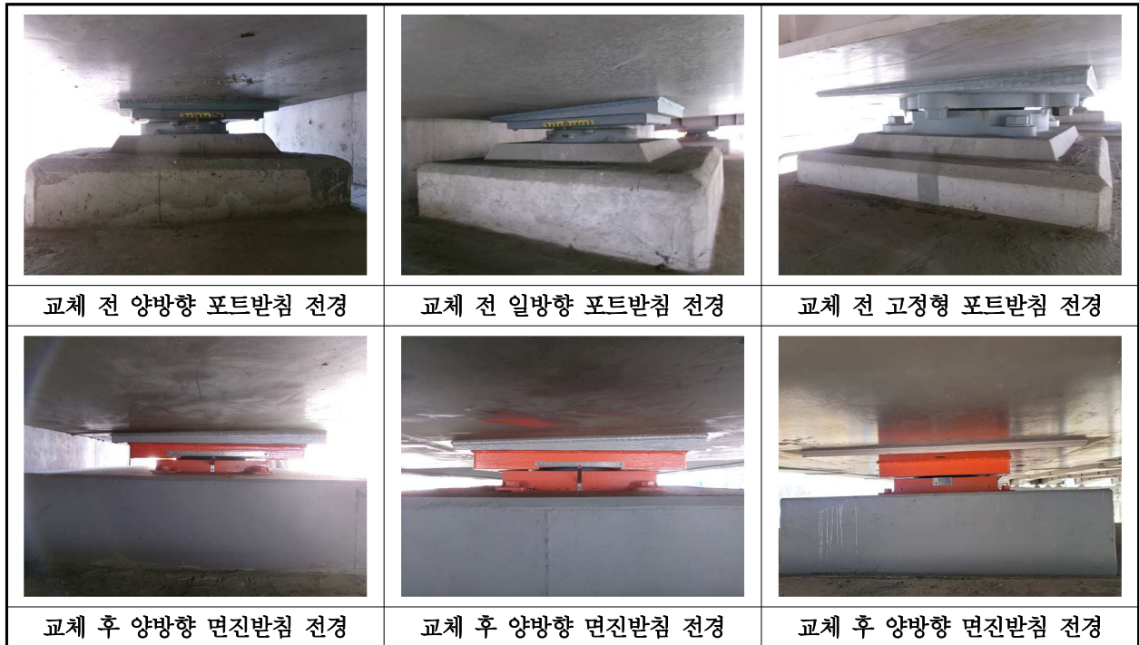
【사진 2.3.14】교량받침 전경
