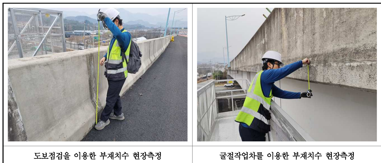
【사진 2.2.1】 부재 현장측정 전경
