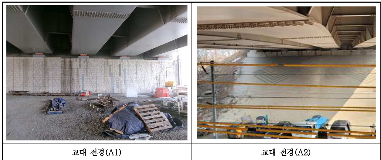
【사진 2.3.8】 교대 전경
