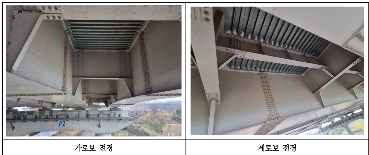
【사진 2.3.36】 가로보 및 세로보 전경
