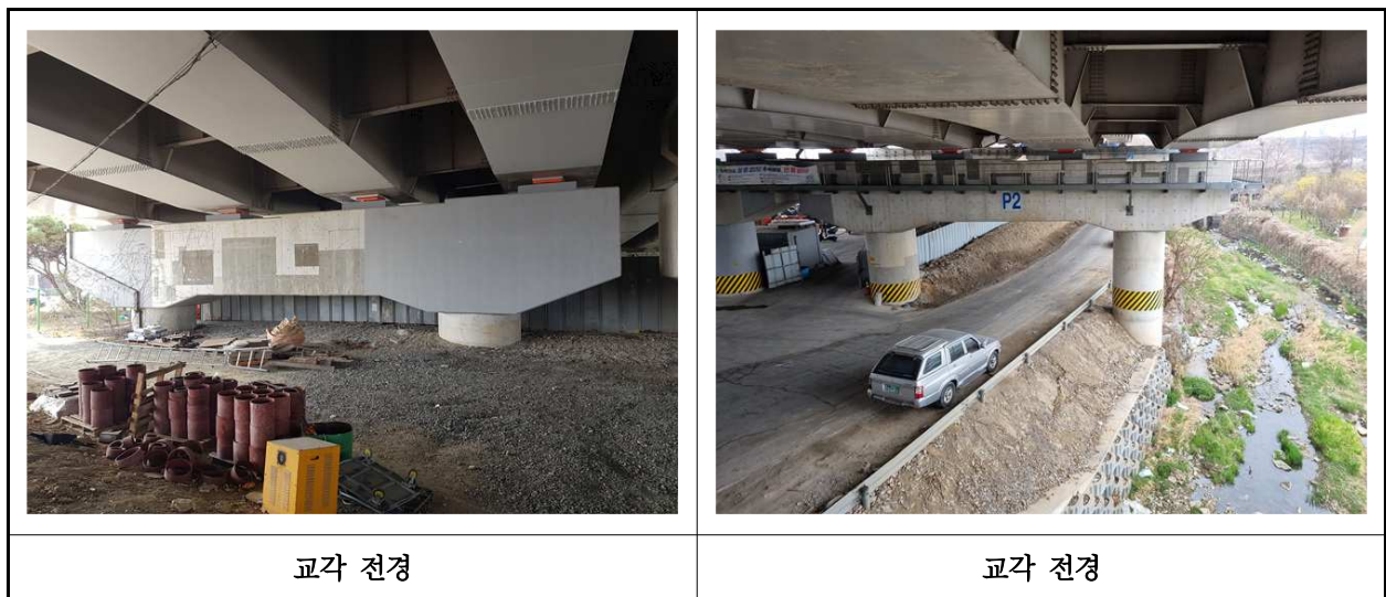
【사진 2.3.41】 교각 전경
