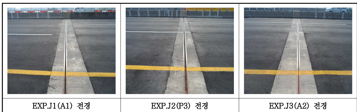
【사진 2.3.18】 신축이음장치 전경
