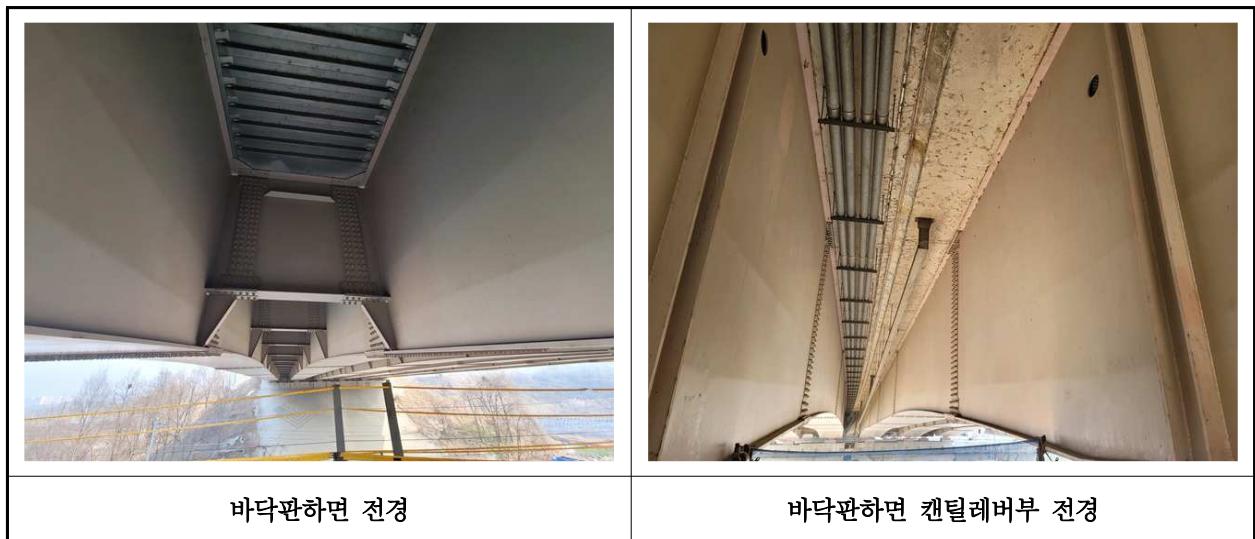
【사진 2.3.2】 바닥판하면 전경
