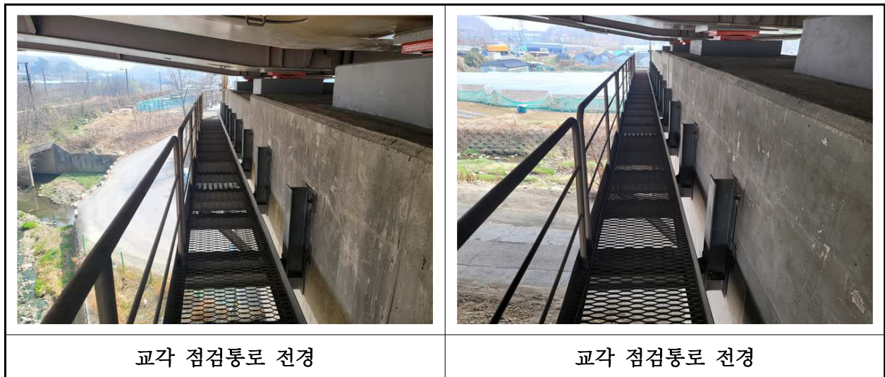
【사진 2.3.57】 교량 점검시설 전경
