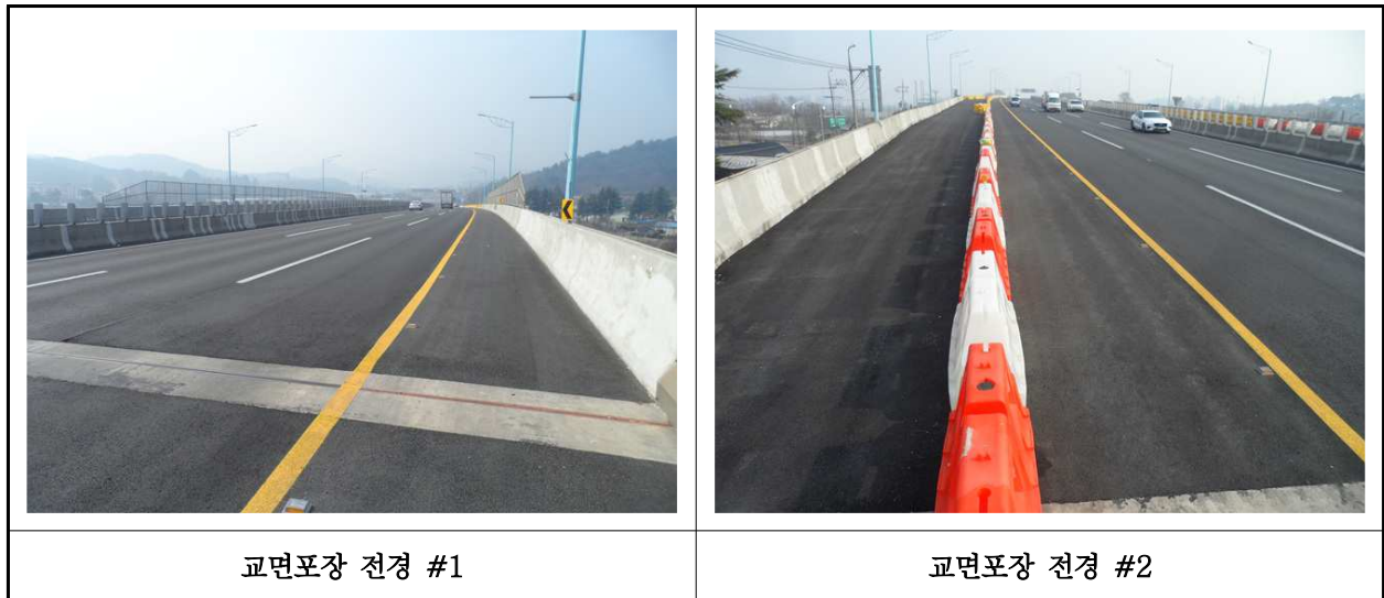
【사진 2.3.21】 교면포장 전경
