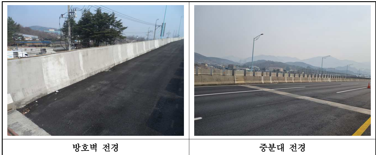
【사진 2.3.25】 방호벽 및 중분대 전경
