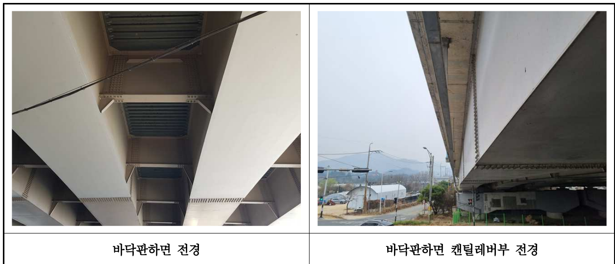
【사진 2.3.32】 바닥판하면 전경
