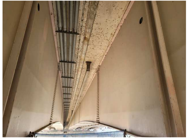
바닥관하면 S4 내측 캔틸레버 상태현황
