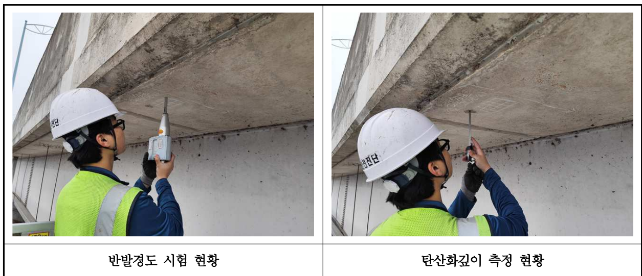
【사진 2.4.1】 콘크리트 내구성조사 현황
