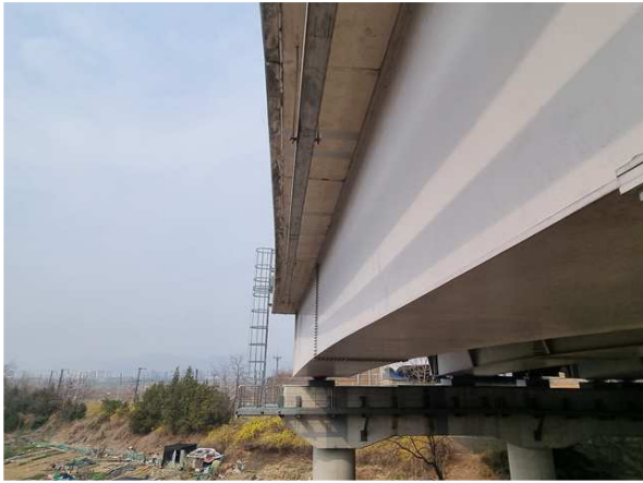
바닥관하면 S3 외측 캔틸레버 상태현황
