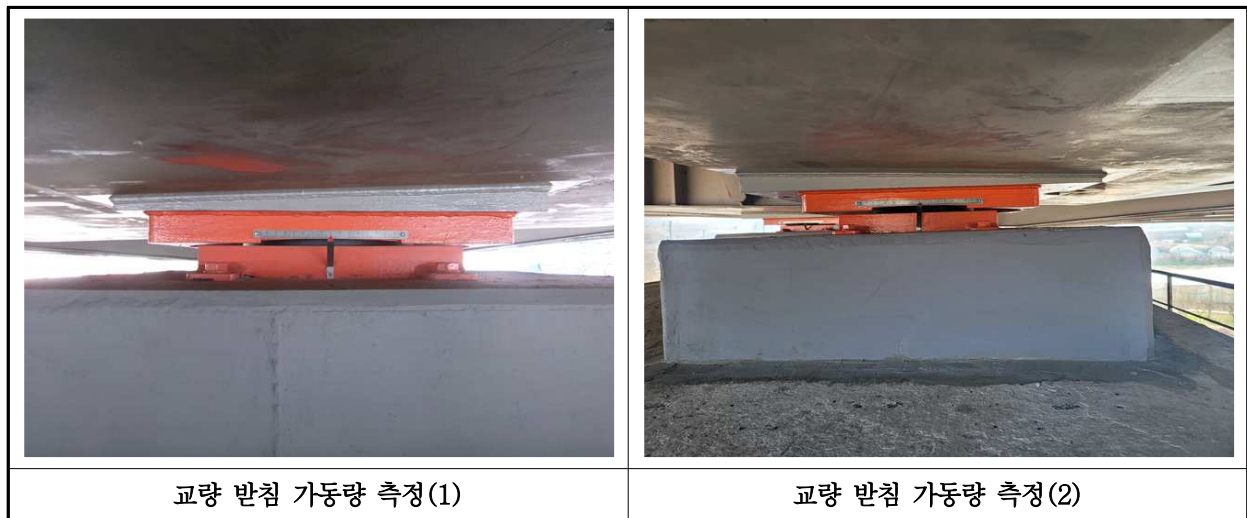
【사진 2.3.47】 교량받침 이동량 측정
