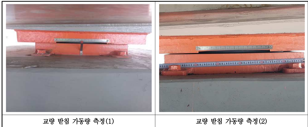
【사진 2.3.17】 교량받침 이동량 측정
