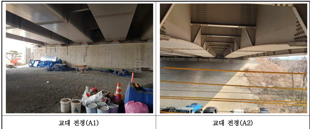
【사진 2.3.38】 교대 전경
